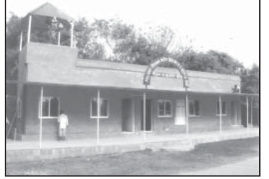
■ आपला माणूस - आपला किरीट ■ 46
